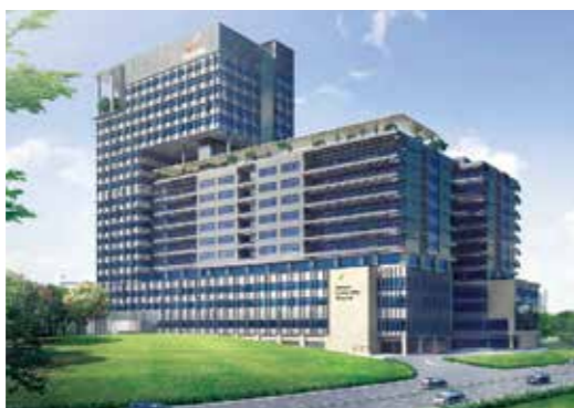
延べ床面積 14万6,000㎡の OCH。SGH と連絡ブリッジでつながっている。
