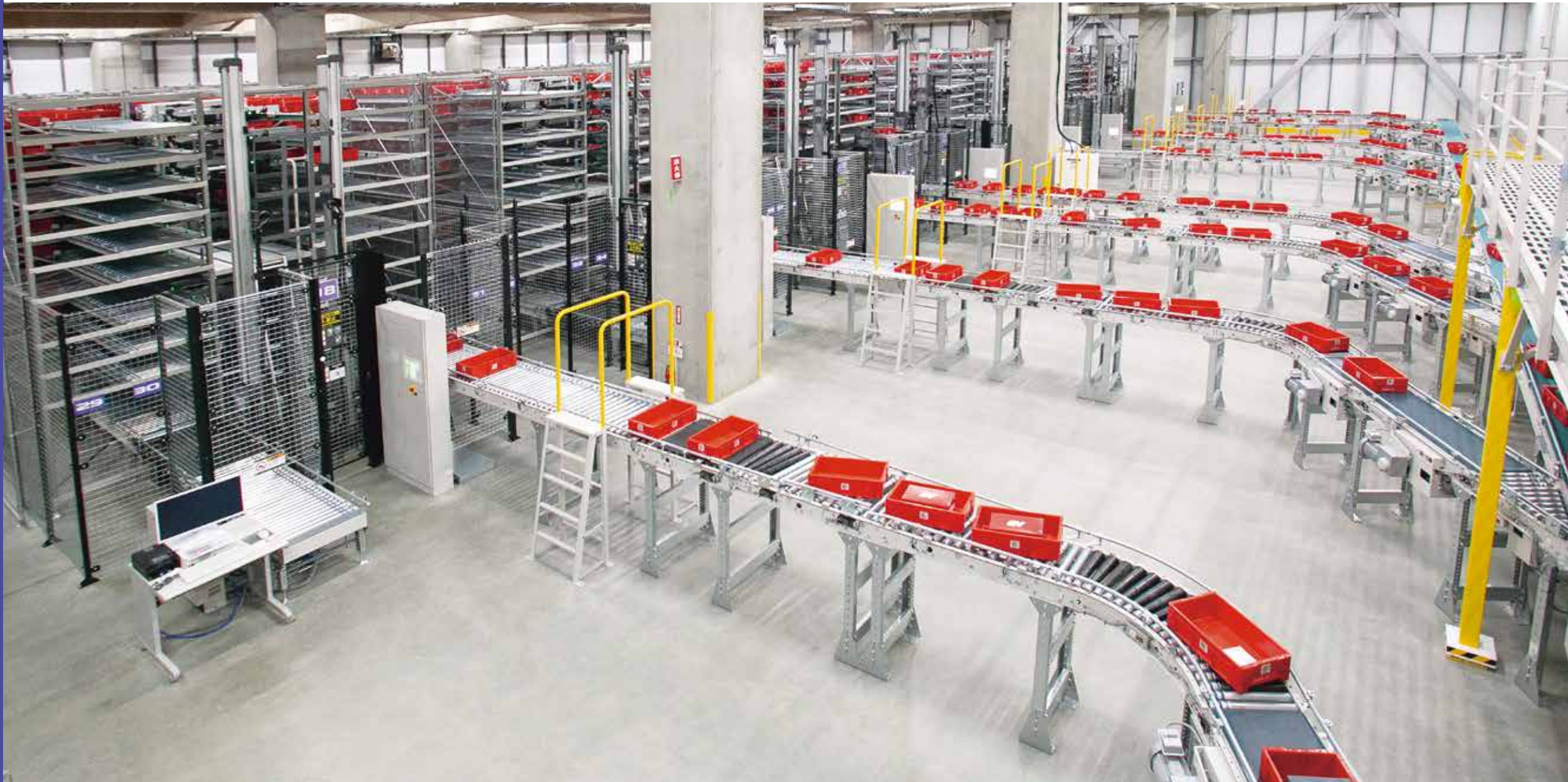
4階に設置された高能力ケース自動倉庫「シャトルラックM」から払い出されるシューズ入りコンテナ。シューズは12足をオーダー単位として、順に箱詰めを行う出庫ステーションに搬送されていく。
