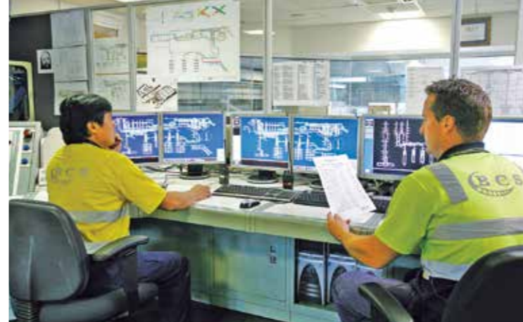
空港内設備監視システム。
