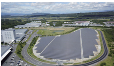
5万2,000m 2 の太陽光パネル
