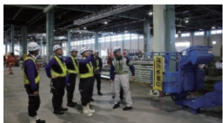
社長による安全衛生パトロール
