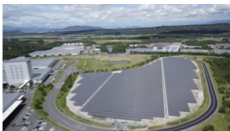
5万2,000m 2 の太陽光パネル
