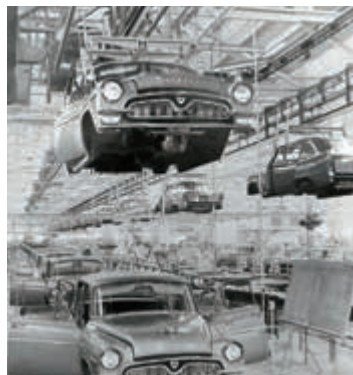
国内初の乗用車専門工場に納入された コンベヤシステム
