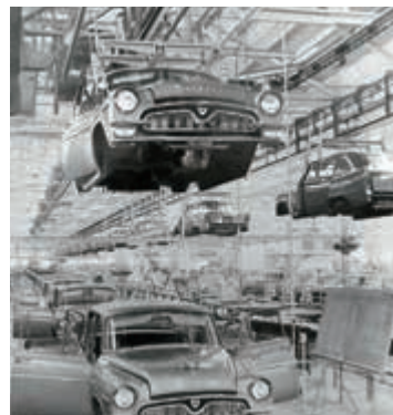
国内初の乗用車専用工場に納入されたコンベヤシステム
