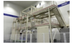
大福自動搬送設備(蘇州)有限公司に導入された安全体感道場
