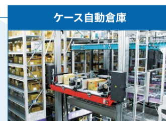
ケース自動倉庫 多種多様なサイズの段ボールケースを 保管
