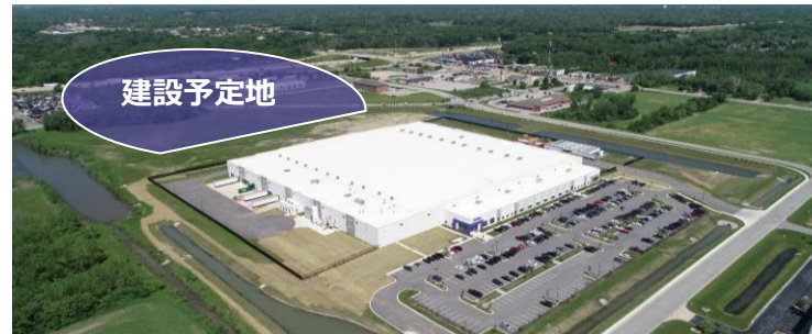
現工場の敷地内に同規模の工場を建設
