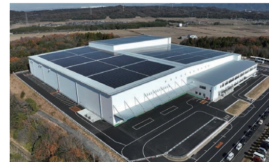
新工場棟（G棟）の外観
