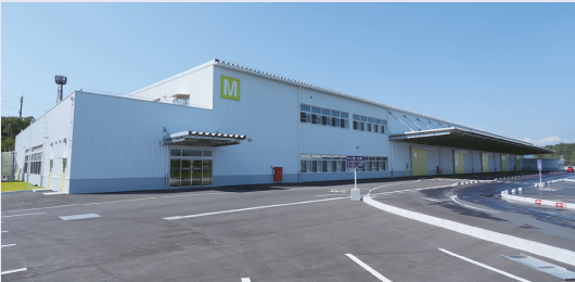
2025年7月に完成した新棟（M棟）
