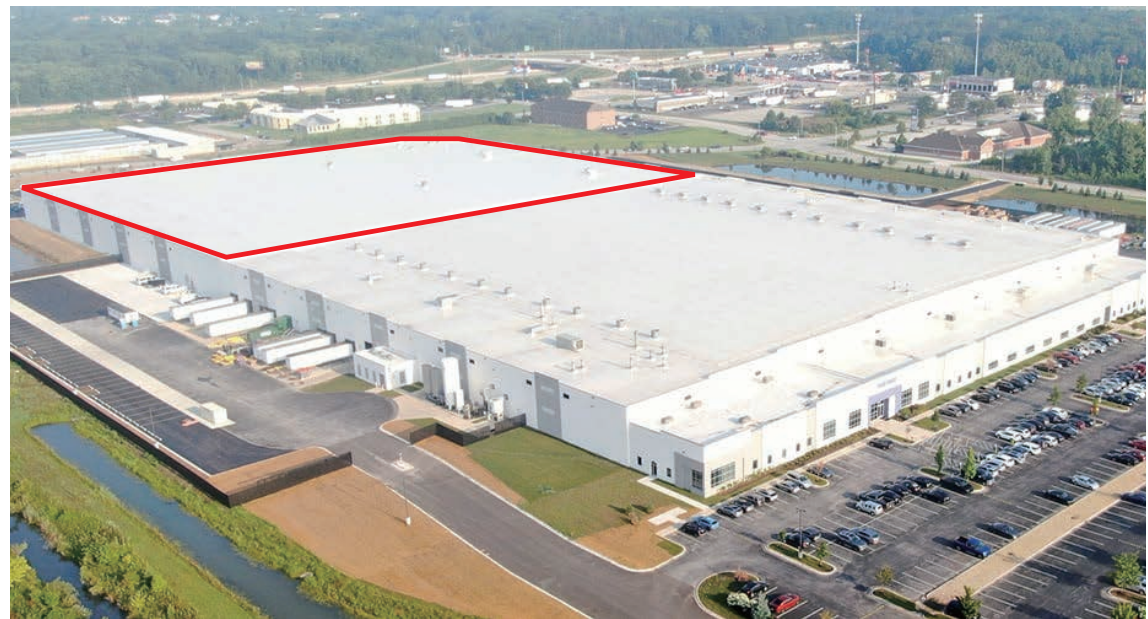
既存工場棟に隣接する米国の新工場棟（赤枠）
