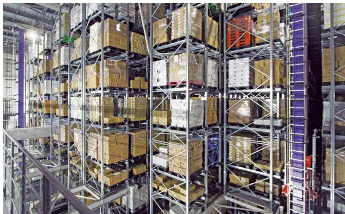
高さ約20mのパレット自動倉庫「コンパクトシステム」は、ダブルディーブ方式を採用し、スタッカークレーンは6基。庫内温度は-25℃で管理されている。
