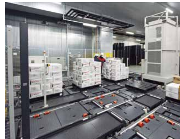
0℃に設定されたピッキングエリアで方面別にまとめてケースピッキングを行う。空パレットの供給も自動化し、効率化を図っている。
