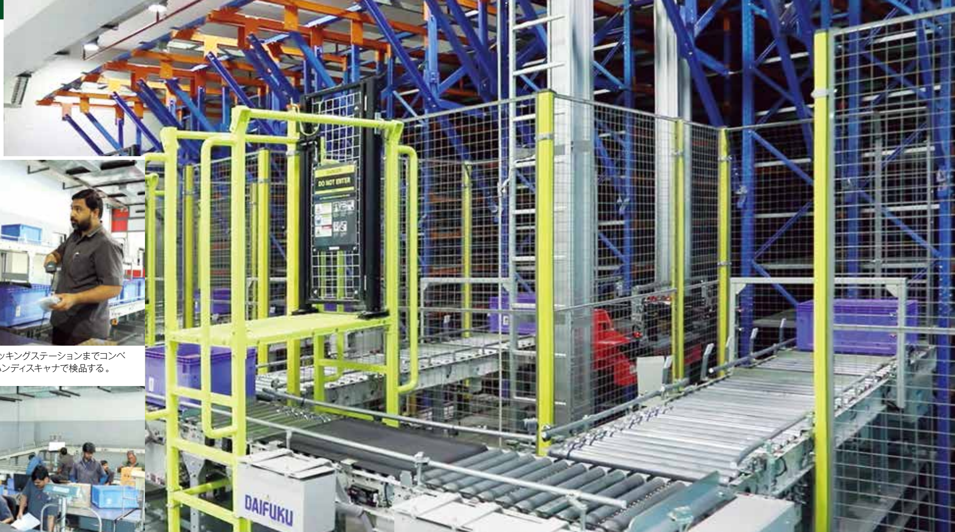
ケース自動倉庫は高さ15m、スタッカークレーン5基を備え、格納数は2万7,360ケース。製品および半製品を保管する。
