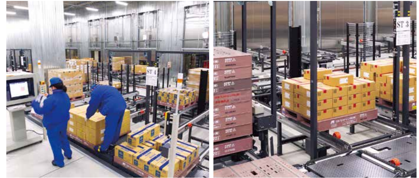
作業者はモニターに表示された指示を確認し、自動倉庫から出庫した商品のケースピッキングを行う。ピッキングした商品を載せる空パレットの供給も自動化している。ピッキングした商品は人手を介さず、1階へ自動搬送される。
