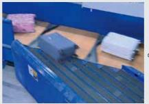
計30カ所ある投入口から連結されたトレイに手荷物 を載せて目的地に搬送する。
