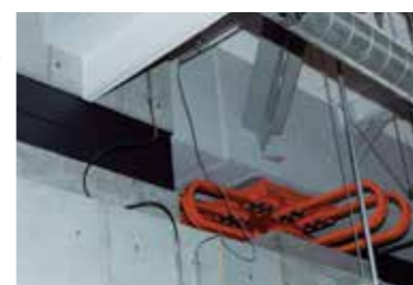
(写真上)入荷検品を行うと、商品の格納場所が自動で指示される。(写真下)災害時にも商品供給が継続できるように免震構造を採用。
