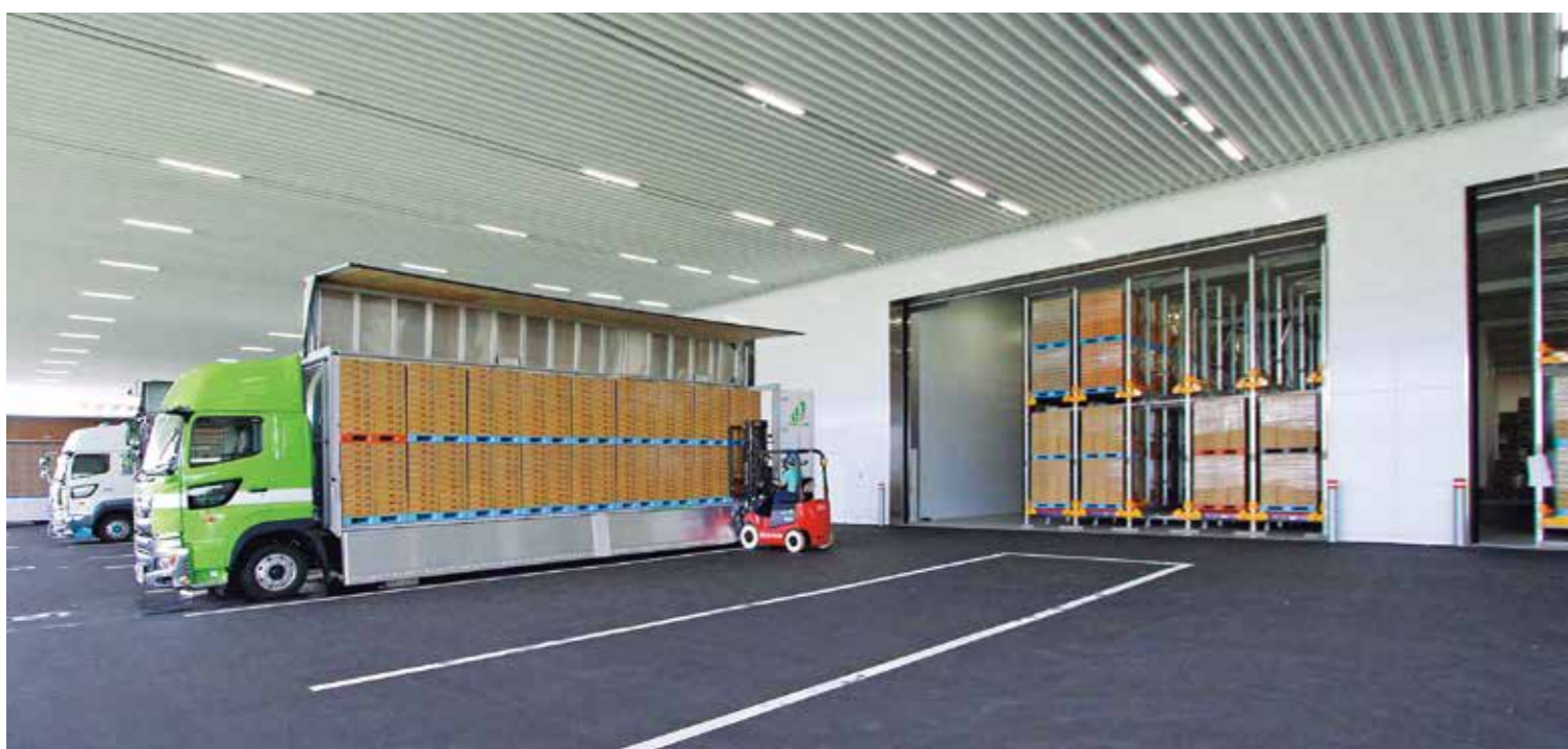
36パレット分の商品を積載したトラック。建屋の開口部付近から商品が出庫できるので、短い搬送距離で積み込みが行える。東海道新幹線の米原・京都間の車窓からその様子の一部を望むことができる。
