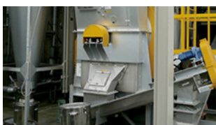
汚泥再資源化施設
