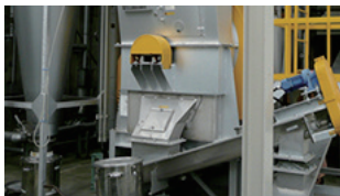
汚泥再資源化施設
