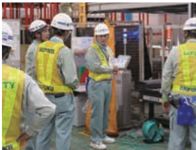
社長による現場安全パトロール
