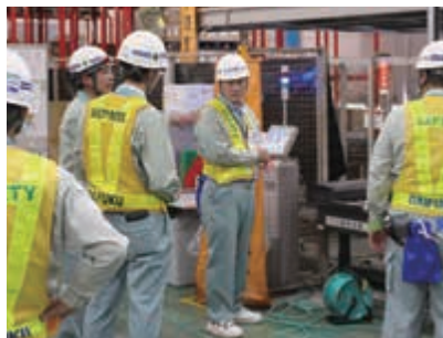
社長による現場安全パトロール
