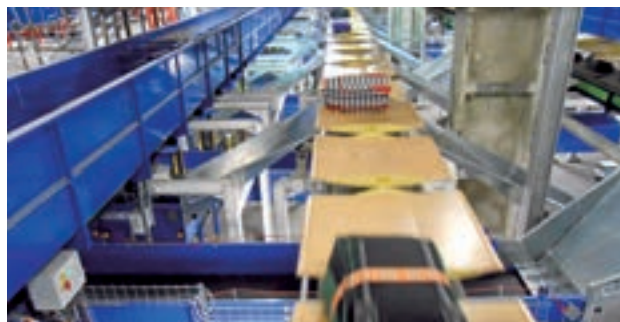
空港向け手荷物搬送システム ABH (Airport Baggage Handling)
