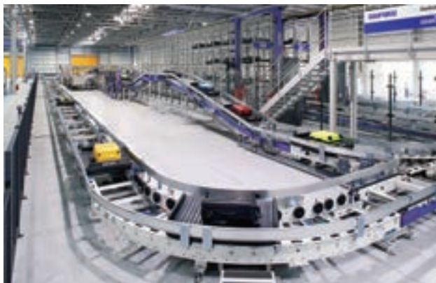
空港向けシステム拡販に展示場設置(滋賀事業所)
