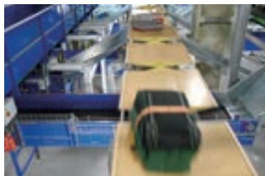
空港向け手荷物搬送システム
