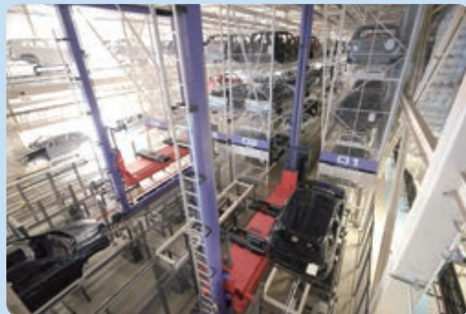
自動車工場で活用される自動倉庫
