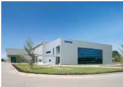
7月に完成したタイ ビントン工場
