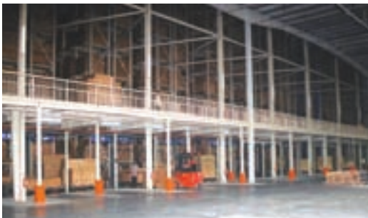
2004年、家具工場に納入した世界最大級の建屋一体型自動倉庫(浙江省) 奥行き300m、幅80m、高さ20mで3万強のパレットを格納
