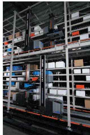
4台のクレーンがシンクロ
