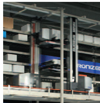
2台のクレーンがすれ違う瞬間
