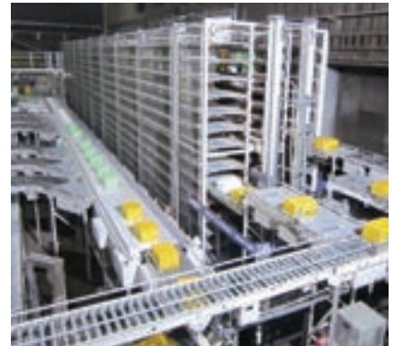
(写真)棚の各段でシャトルが走行するシャトルラック
