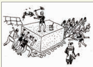
動力を人力に頼っていた時代のマテハン (巨石の運搬)
