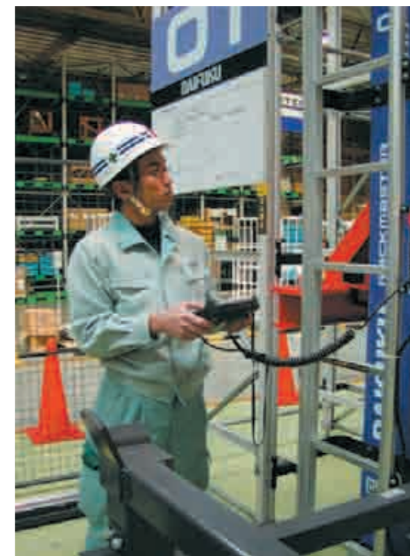
自動倉庫のメンテナンス作業
