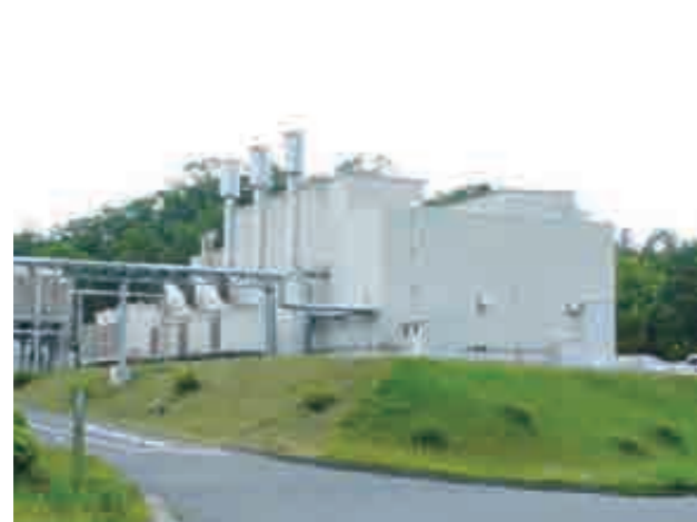
コージェネレーションシステムによる自家発電
