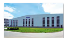
大福自動搬送設備(蘇州)
