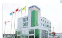
大福(中国) 自動化設備
