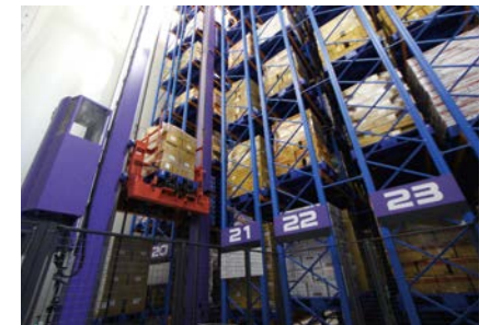
タイの食品メーカーに納入した冷凍自動倉庫
