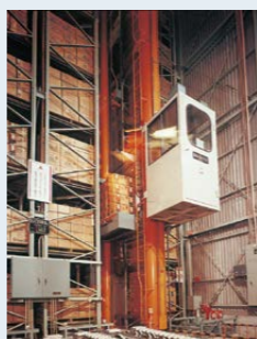
「ラックビル」1号機
