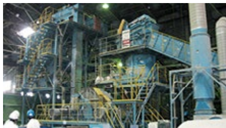
当社社員による現地確認
