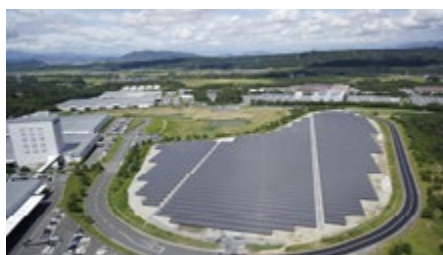
5万2,000平方メートルの太陽光パネル
