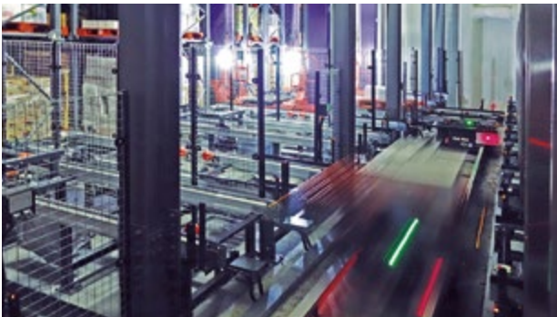
地震対策を施した自動倉庫
