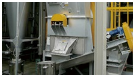
汚泥再資源化施設
