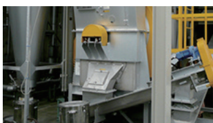
汚泥再資源化施設
