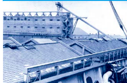
バルクベヤ 日本初の穀物・バラ物の荷揚げ設備
