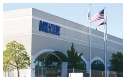
フェアフィールド物流センター
