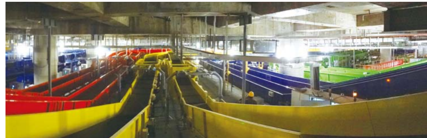
コンベヤライン。16カ所のチェックインアイランドを4つに区分し、どの系統がすぐに判別できるように色分けしている
