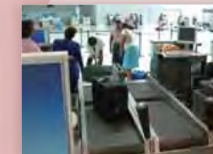
チェックインカウンター：手荷物搬送システム
