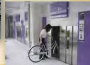
駐輪場：機械式立体駐輪システム
