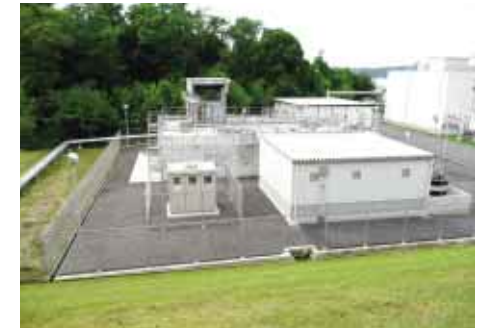
排水処理場(滋賀事業所)
