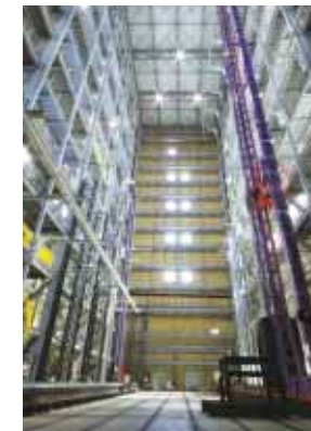
高層研究棟で試運転を行うラックマスター(滋賀事業所)
