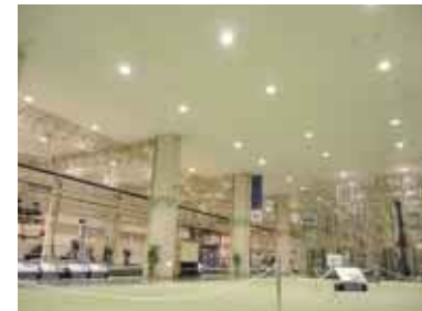
フロア全体の水銀灯をセラミック発光管に交換
