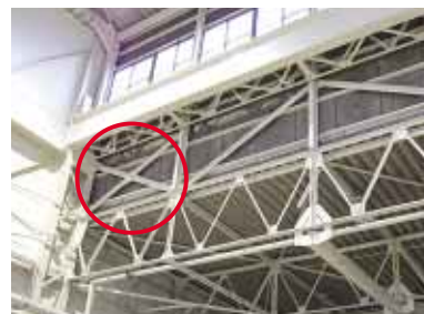
補強部プレスを追加(滋賀C棟)
