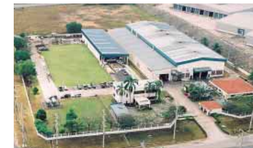
Daifuku (Thailand) Ltd. チョンプリ工場
