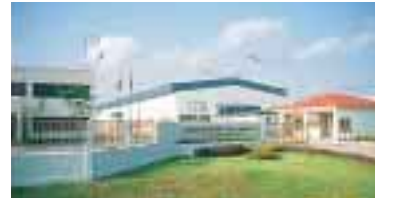
Daifuku (Thailand) Ltd. チョンブリ工場
