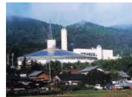
環境センターと温水プール
